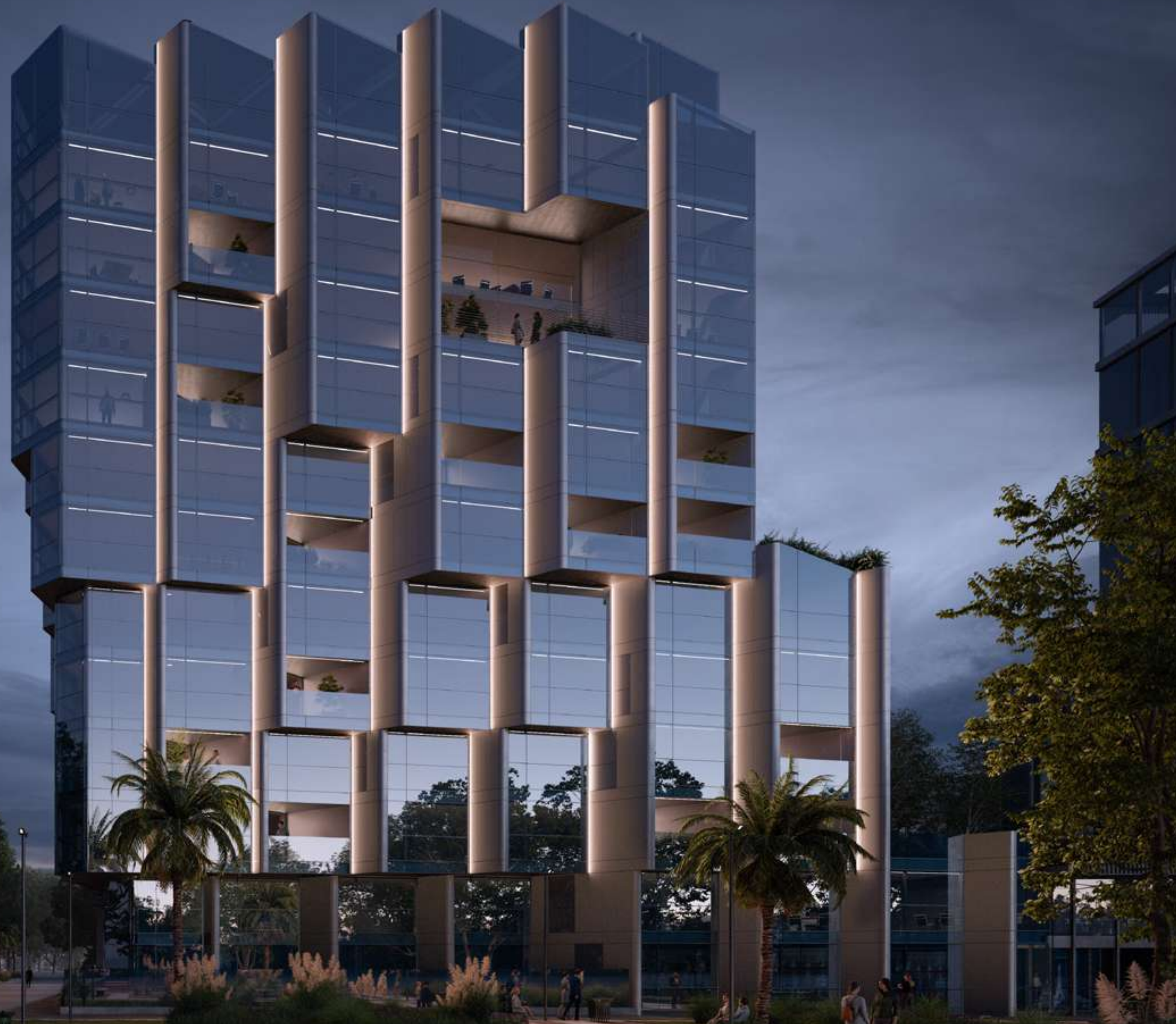
Fachada norte nocturna con vista al Río de la Plata.
